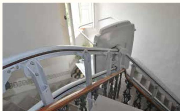
**Meccanica di trasmissione a doppio pignone**, massima robustezza interna per un movimento unico e preciso
